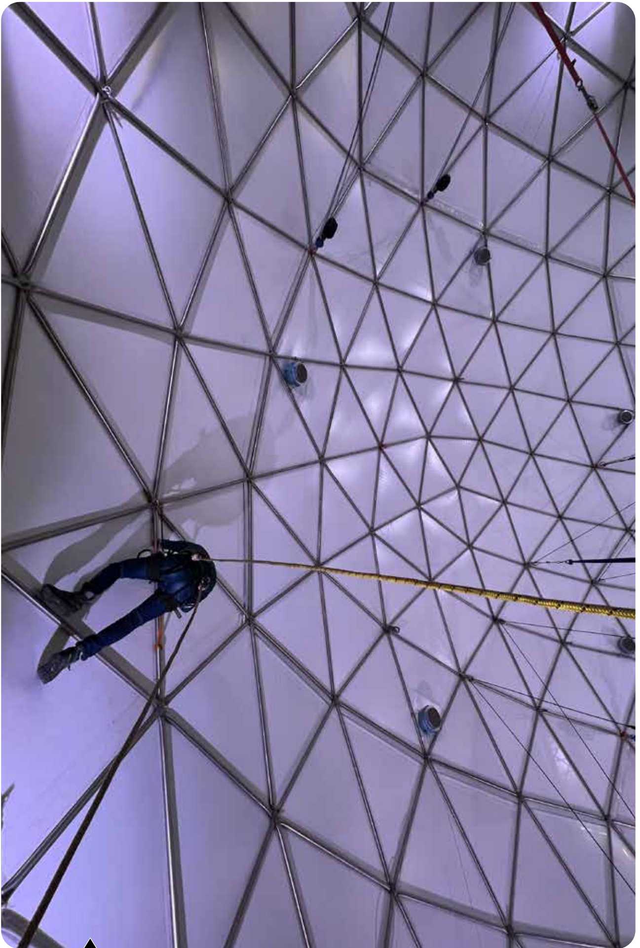
▲ Travail en hauteur dans le dôme du Komonò
